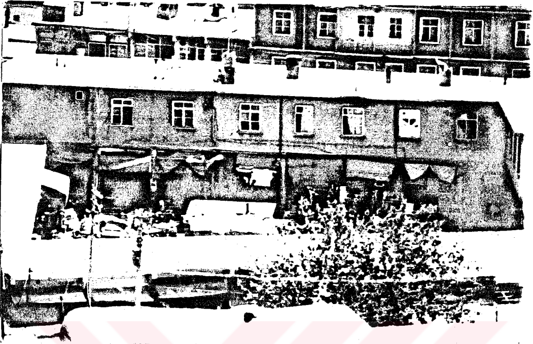
FOTO, 7: Siverek Belediyesi Binası ve Alt Katta Siverek Sebze Hali (1989)
