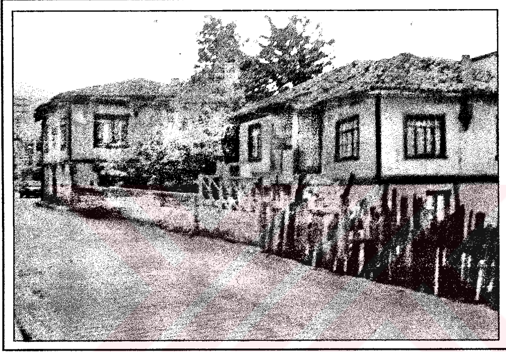
Fotoğraf: 15 Şehirde yer alan bağıdadi yapı tarzlı konutlardan bir görünüm.
