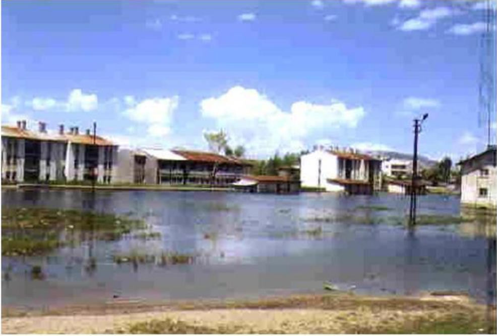
Foto 2: Van'ın İskele Mahallesinde Göl Suyu İçerisinde Kalan Evler (Yıldız ve Deniz, 2005).
