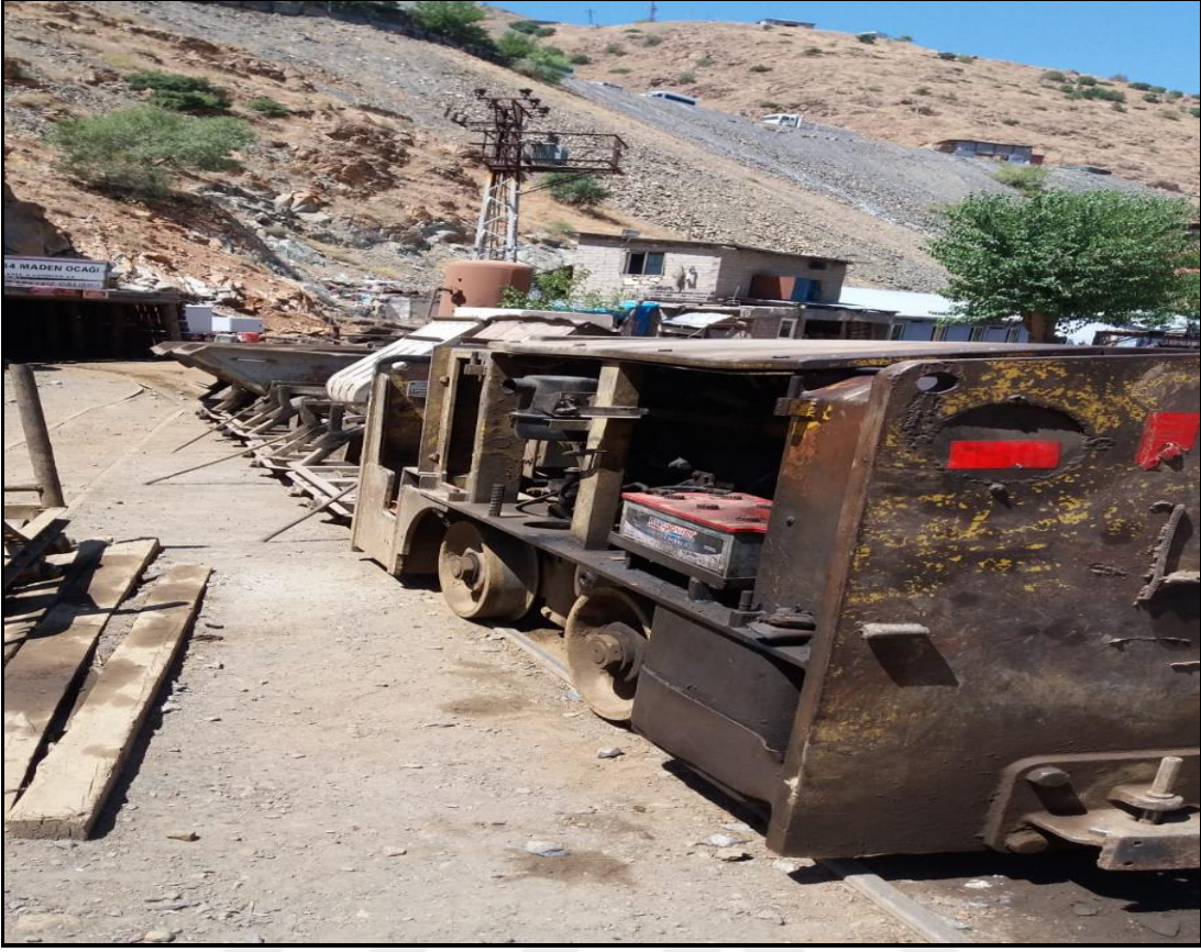
Foto 35. 1035 nolu galeriden raylı sistemle krom taşımacılığına ait görünüm
