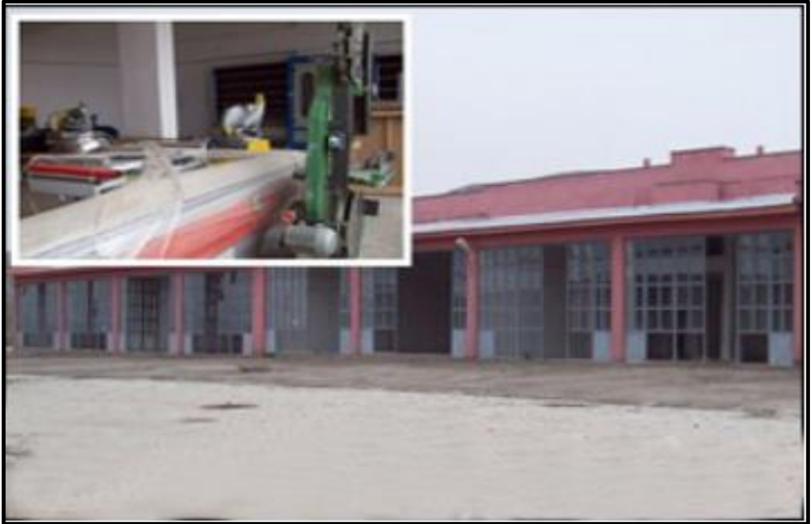
Foto 9: Solhan(Bingöl)Küçük Sanayi sitesinden Bir Görünüm.
