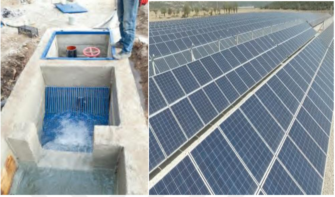
Şekil 5. Tarımsal sulamada kullanılmak üzere yapraklı sulama tesisi yapımı ve güneş enerjisi santrali kurulumu
