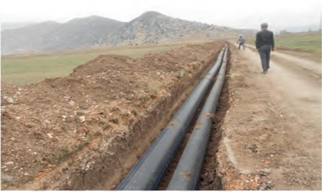
Şekil 6. Sulama amaçlı boruların döşenmesi
