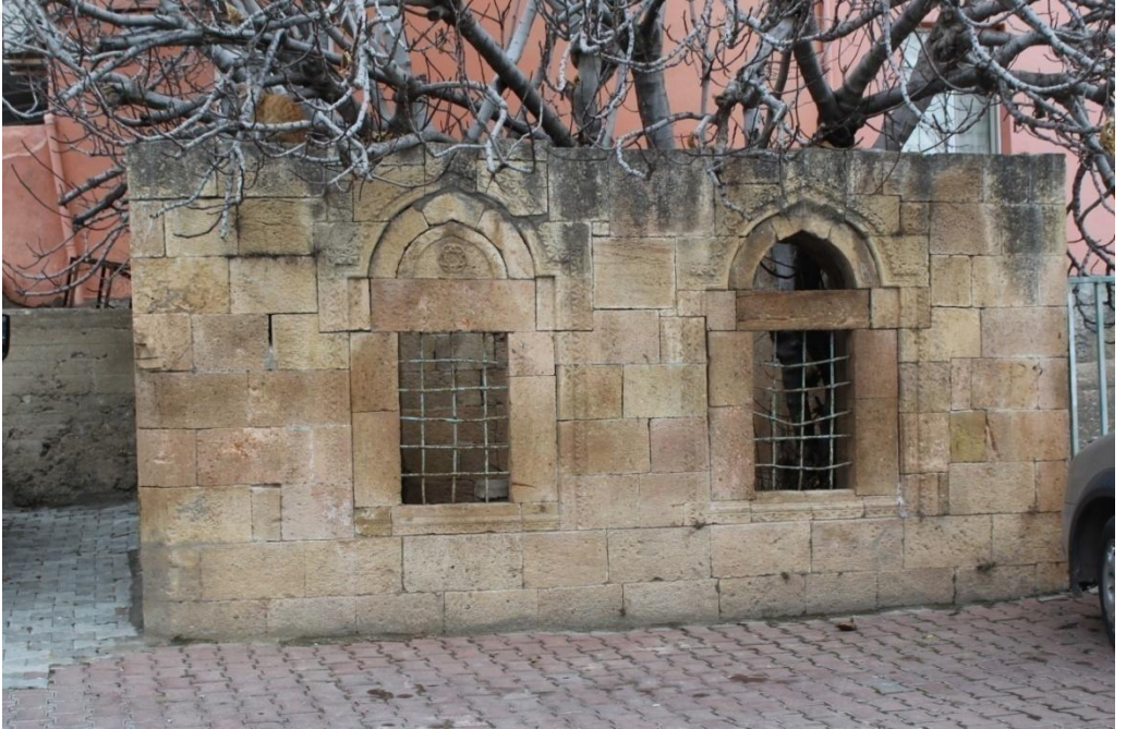
Fotoğraf 155. Keban Yusuf Ziya Paşa Külliyesi'nin Fırat Mahallesi'nde Yusuf Ziya Paşa'nın Kızlarına Ait Türbe Güney Duvarı
