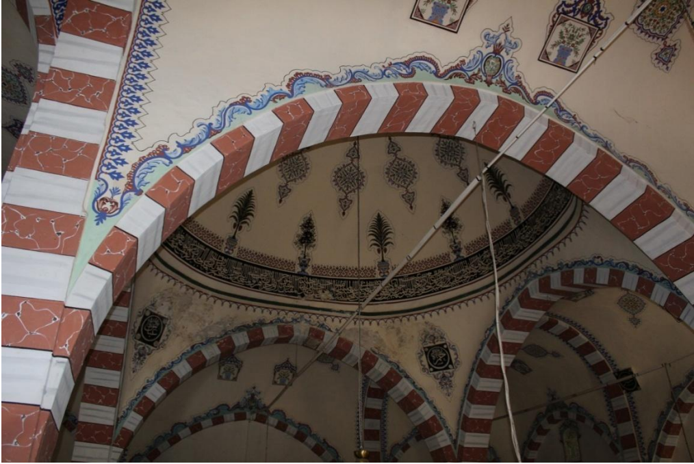
Fotoğraf 86. Keban Yusuf Ziya Paşa Camii Merkezi Kubbe
