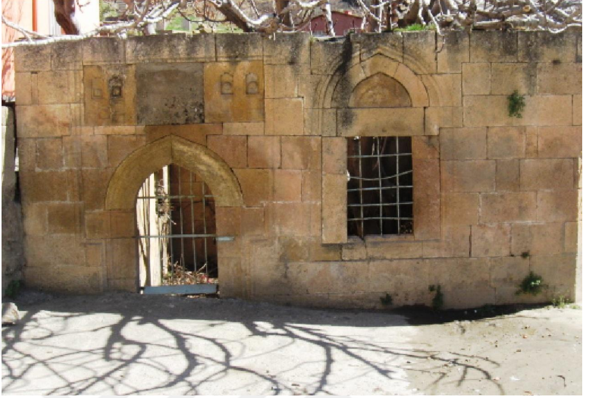
Fotoğraf 154. Keban Yusuf Ziya Paşa Külliyesi'nin Fırat Mahallesi'nde Yusuf Ziya Paşa'nın Kızlarına Ait Türbe Batı Duvarı
