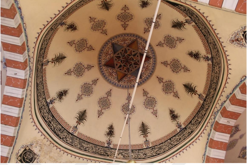
Fotoğraf 85. Keban Yusuf Ziya Paşa Camii Merkezi Kubbe
