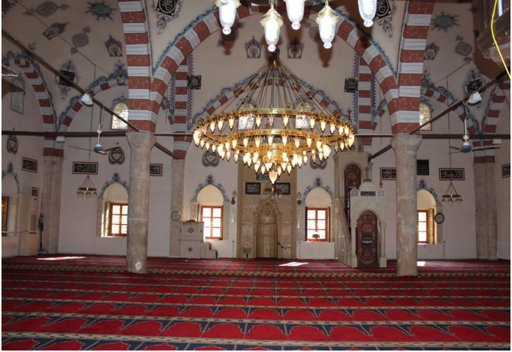
Fotoğraf 77. Keban Yusuf Ziya Paşa Camii Harim Güney Duvar
