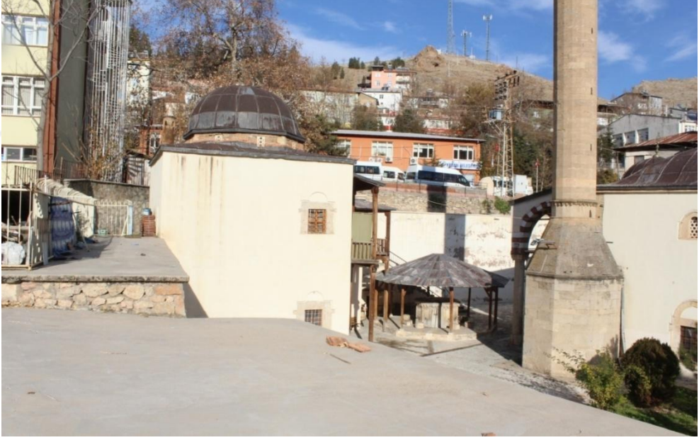
Fotoğraf 120. Keban Yusuf Ziya Paşa Külliyesi Kütüphane Güney Cephe
