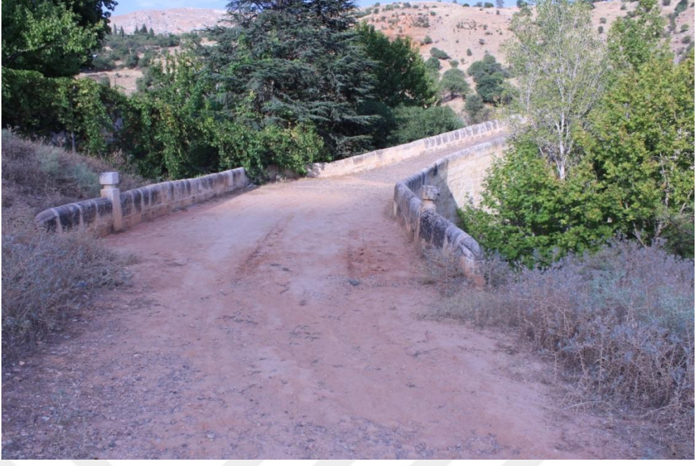
Fotoğraf 208. Tunceli Çemişgezek Tağar (Yusuf Ziya Paşa) Köprüsü Batı Cephe
