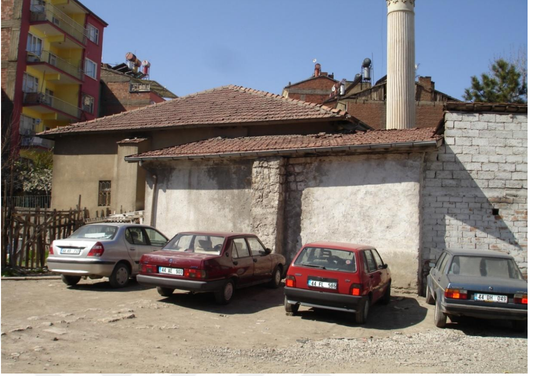
Fotoğraf 31. Malatya Yusuf Ziya Paşa Camii ve Türbesinin Restorasyon Öncesi
