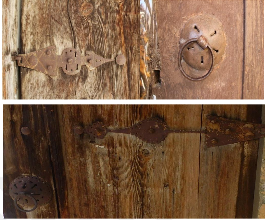
Fotoğraf 55. Keban Yusuf Ziya Paşa Külliyesi Avluya Giriş Kapı Katlarındaki Metal İşçiliği Örnekleri
