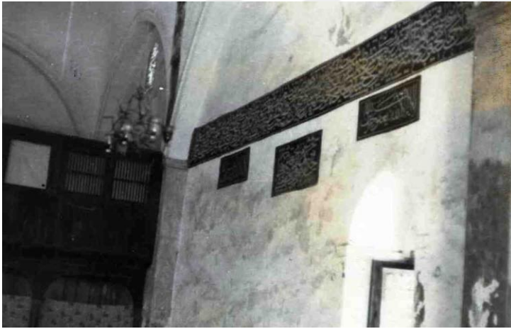
Fotoğraf 114. Keban Yusuf Ziya Paşa Camii Harim Doğu Duvarı Eski Fotoğraf (VGM Arşivi)
