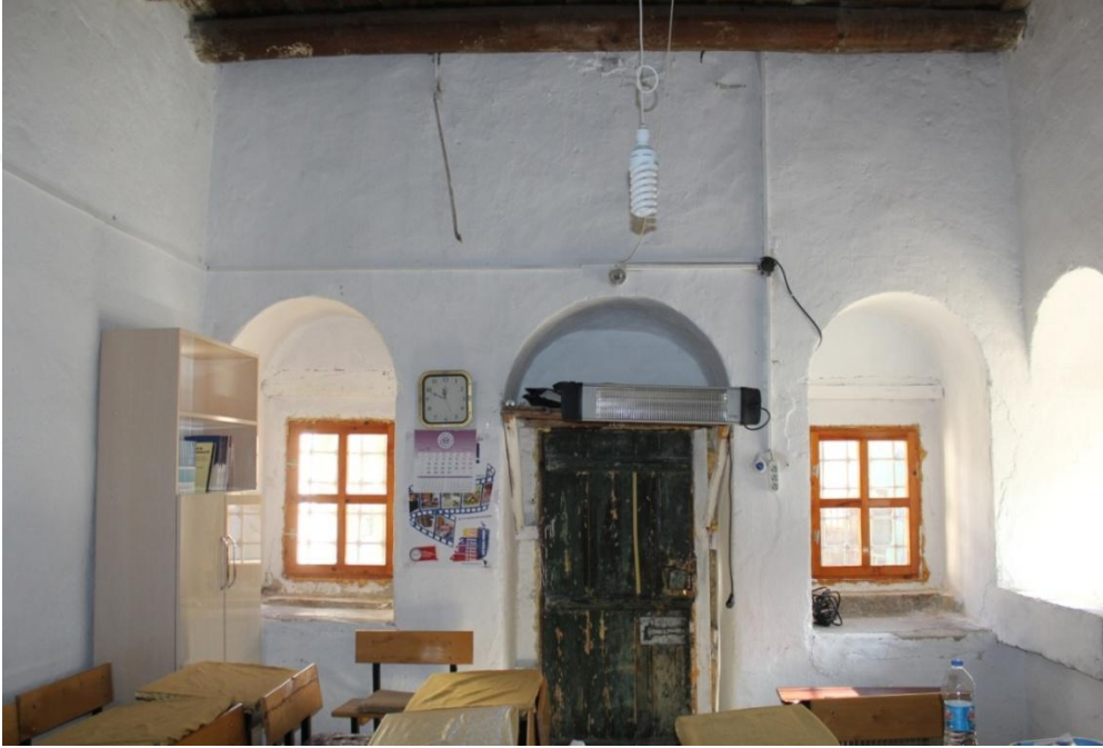
Fotoğraf 122. Keban Yusuf Ziya Paşa Külliyesi Kütüphane Zemin Kat Giriş Kapısı
