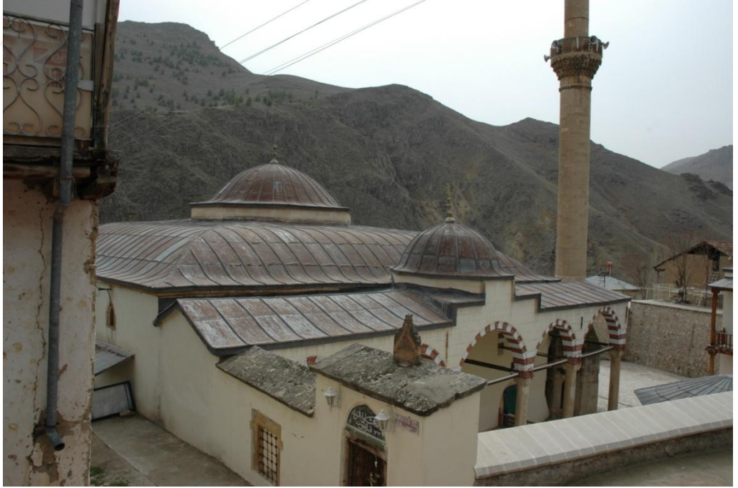
Fotoğraf 56. Keban Yusuf Ziya Paşa Camii Kuzey Cephe
