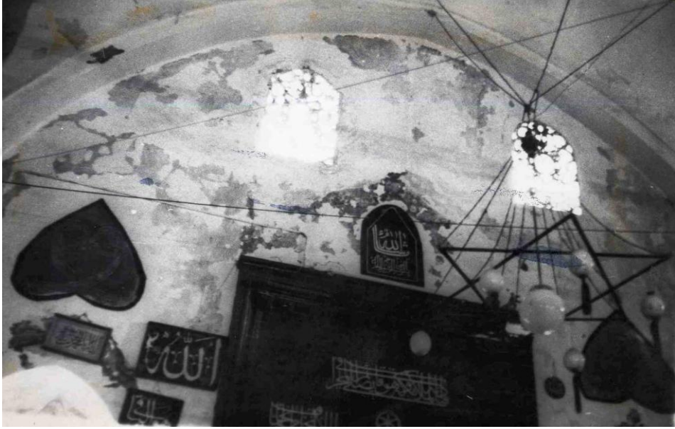
Fotoğraf 116. Keban Yusuf Ziya Paşa Camii Harim Doğu Duvarı Eski Fotoğraf (VGM Arşivi)
