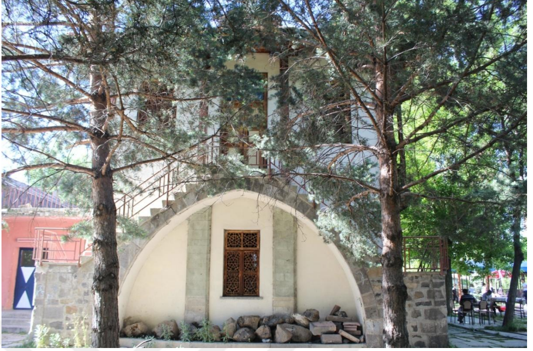
Fotoğraf 184. Erzurum Palandöken Yusuf Ziya Paşa (Nüzhet-ül Hazra) Köşkü Güney Cephe Merdivenler
