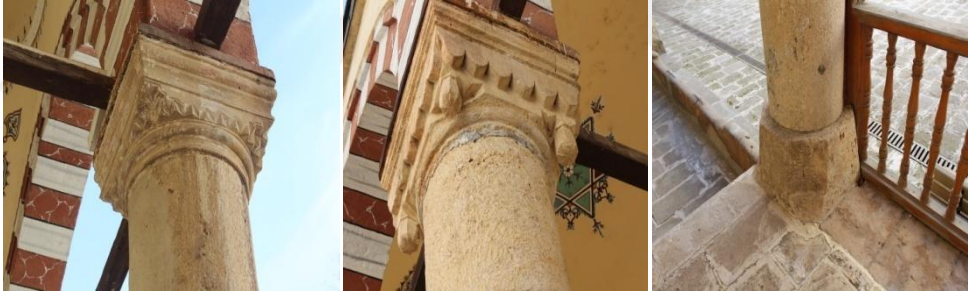
Fotoğraf 76. Keban Yusuf Ziya Paşa Camii Son Cemaat Yeri Sütun Başlık Ve Kaide Detayı
