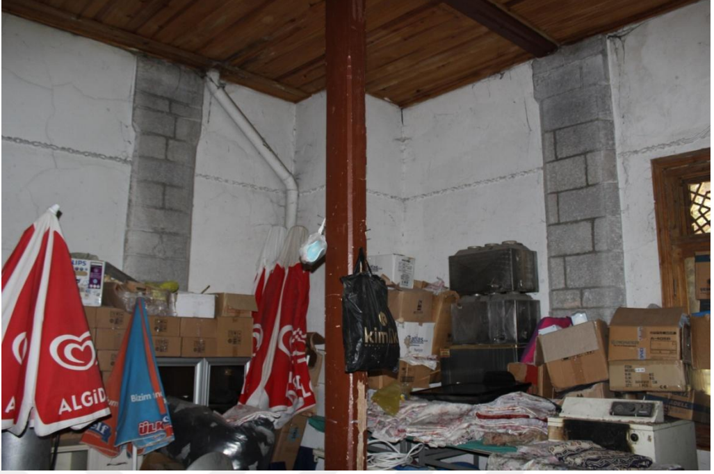
Fotoğraf 186. Erzurum Palandöken Yusuf Ziya Paşa (Nüzhet-ül Hazra) Köşkü Zemin Kat
