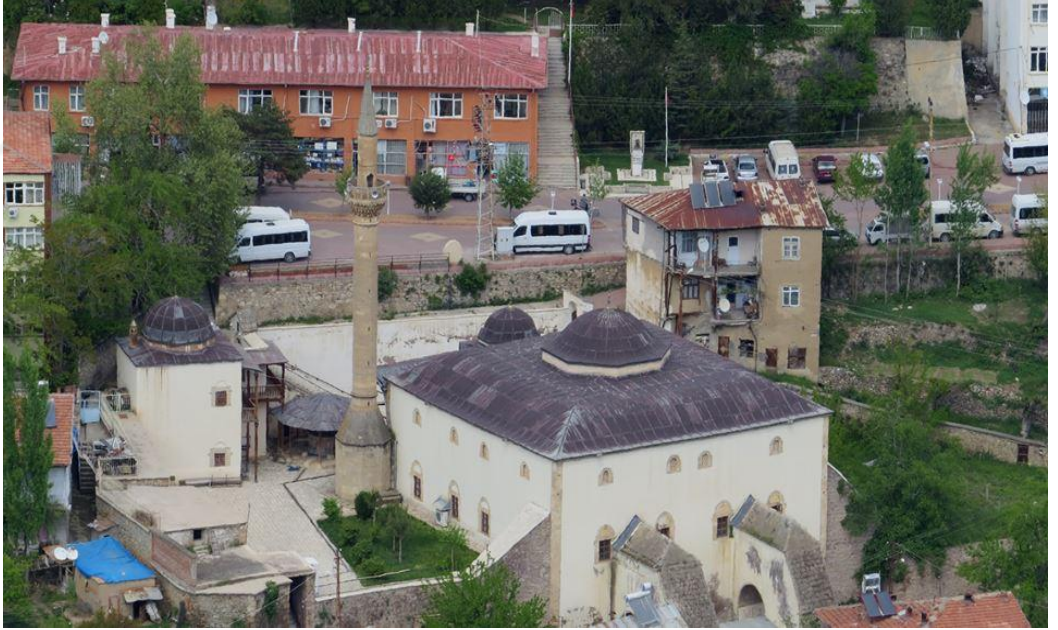
Fotoğraf 60. Keban Yusuf Ziya Paşa Camii Güney İstinat Duvarı Ve Payandalar (Sait BİLGİN)
