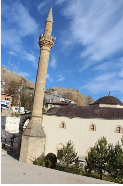
Fotoğraf 107. Keban Yusuf Ziya Paşa Camii Minaresi
