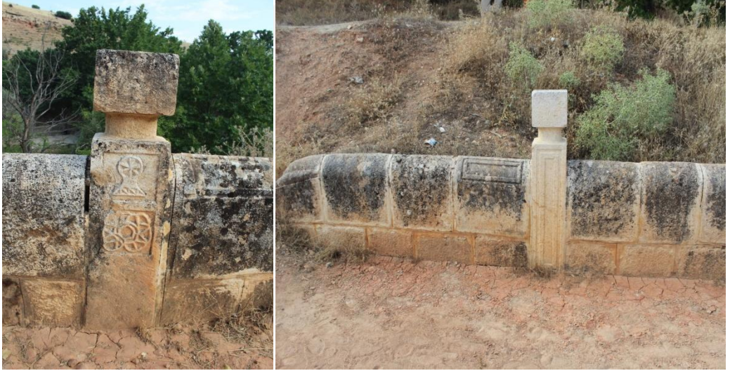
Fotoğraf 211. Tunceli Çemişgezek Tağar (Yusuf Ziya Paşa) Köprüsü Babataşları
