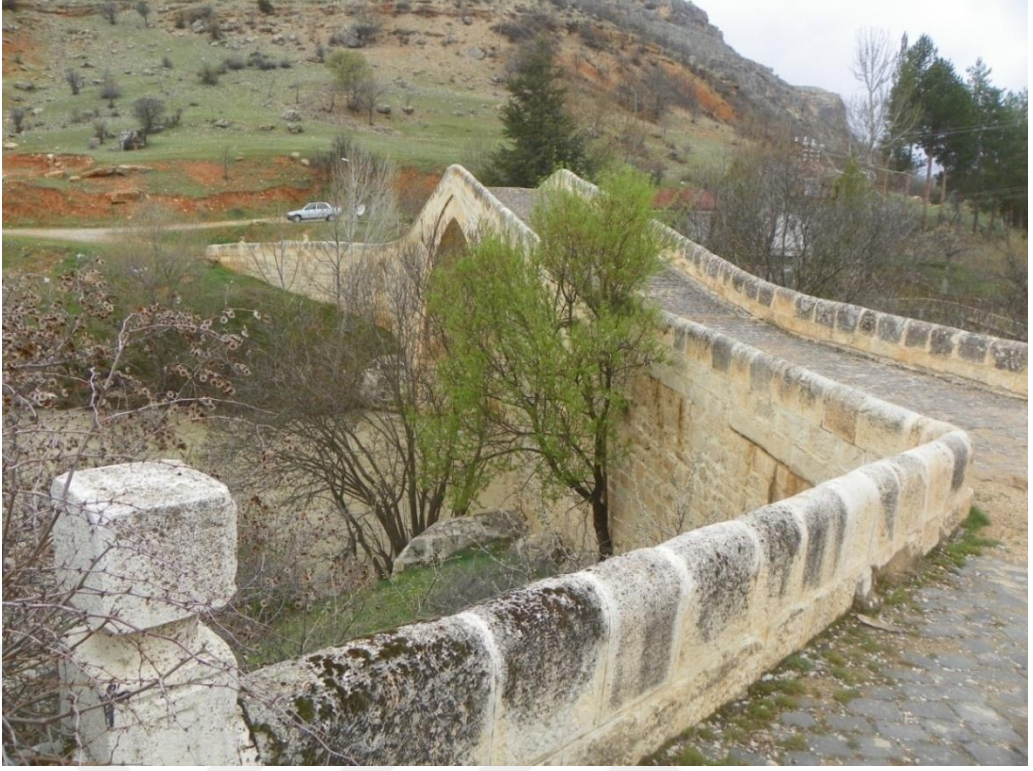
Fotoğraf 206. Tunceli Çemişgezek Tağar (Yusuf Ziya Paşa) Köprüsü Kuzey Cephe
