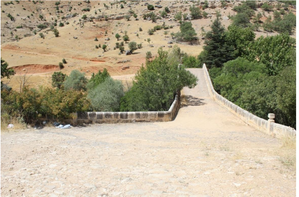
Fotoğraf 207. Tunceli Çemişgezek Tağar (Yusuf Ziya Paşa) Köprüsü Doğu Cephe
