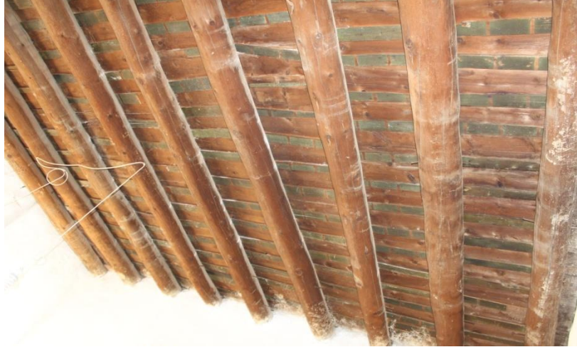
Fotoğraf 123. Keban Yusuf Ziya Paşa Külliyesi Kütüphane Zemin Kat Örtü Sistemi
