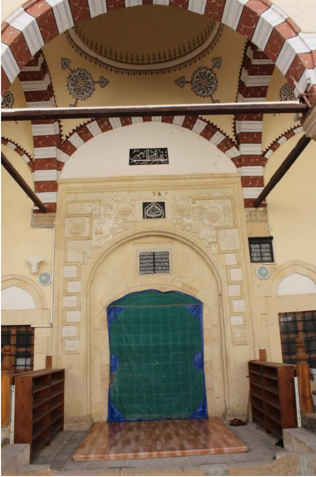
Fotoğraf 70. Keban Yusuf Ziya Paşa Camii Taç Kapısı
