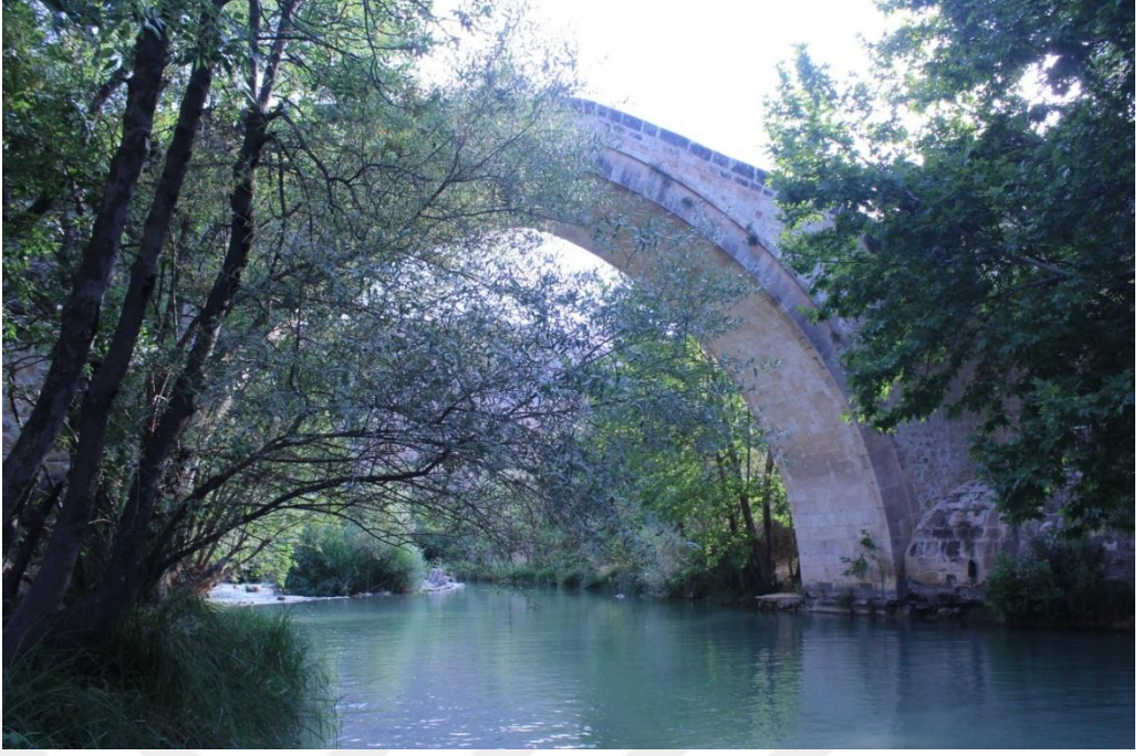
Fotoğraf 210. Tunceli Çemişgezek Tağar (Yusuf Ziya Paşa) Köprüsü Kuzey Cephe
