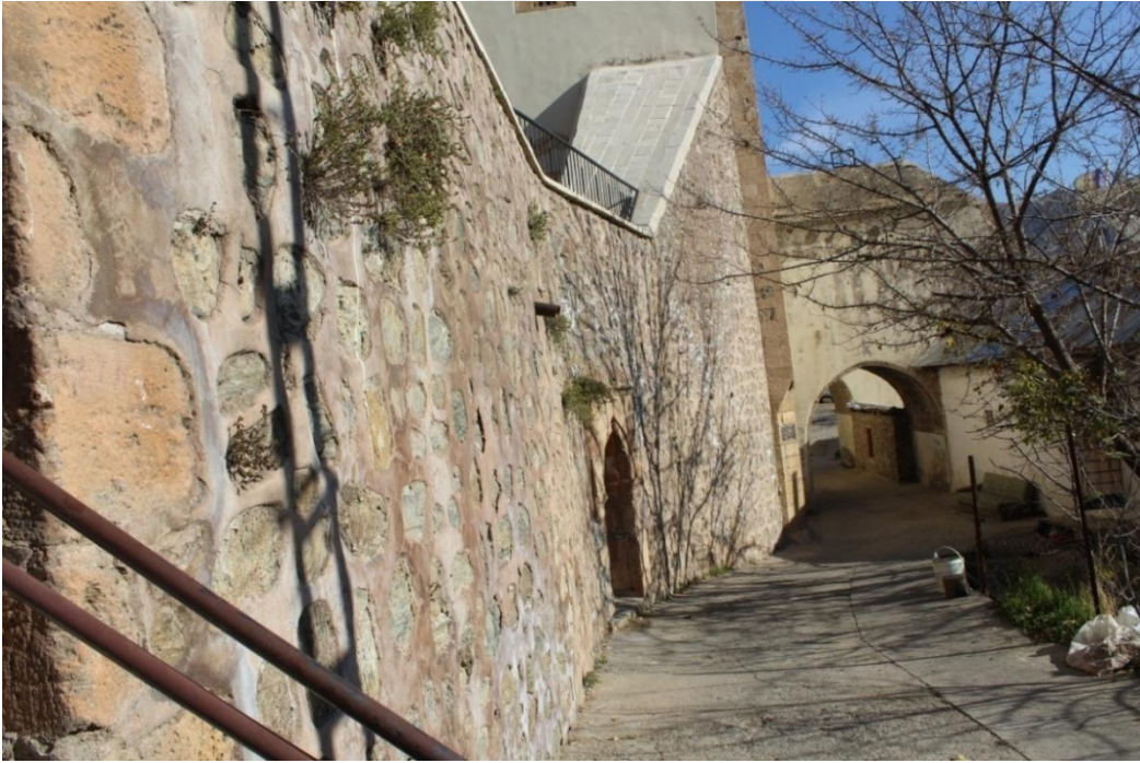
Fotoğraf 62. Keban Yusuf Ziya Paşa Camii Güney İstinat Duvarı ve Payandalar
