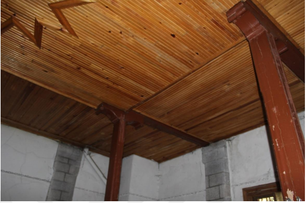
Fotoğraf 188. Erzurum Palandöken Yusuf Ziya Paşa (Nüzhət-ül Hazra) Köşkü Zemin Kat Üst Örtü
