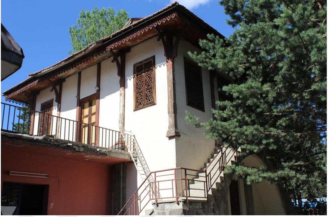
Fotoğraf 190. Erzurum Palandöken Yusuf Ziya Paşa (Nüzhet-ül Hazra) Köşkü Üst Kat Merdivenler
