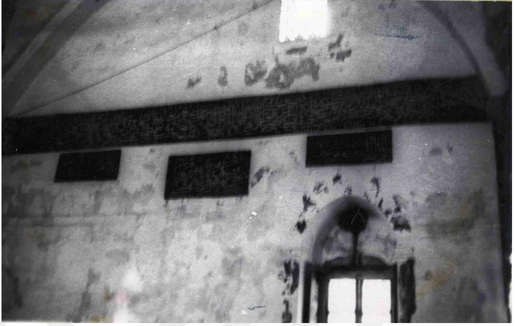
Fotoğraf 113. Keban Yusuf Ziya Paşa Camii Harim Doğu Duvarı Eski Fotoğraf (VGM Arşivi)
