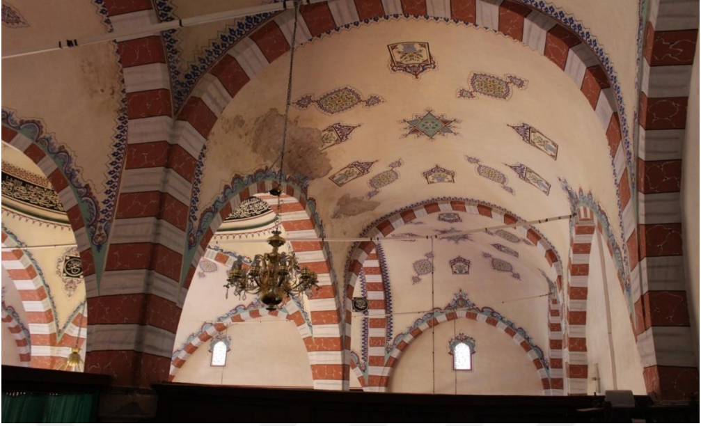
Fotoğraf 83. Keban Yusuf Ziya Paşa Camii Üst Örtü Sistemi
