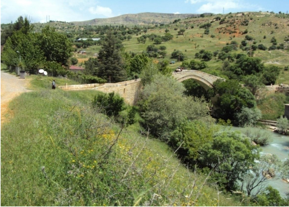
Fotoğraf 205. Tunceli Çemişgezek Tağar (Yusuf Ziya Paşa) Köprüsü Güney Cephesi
