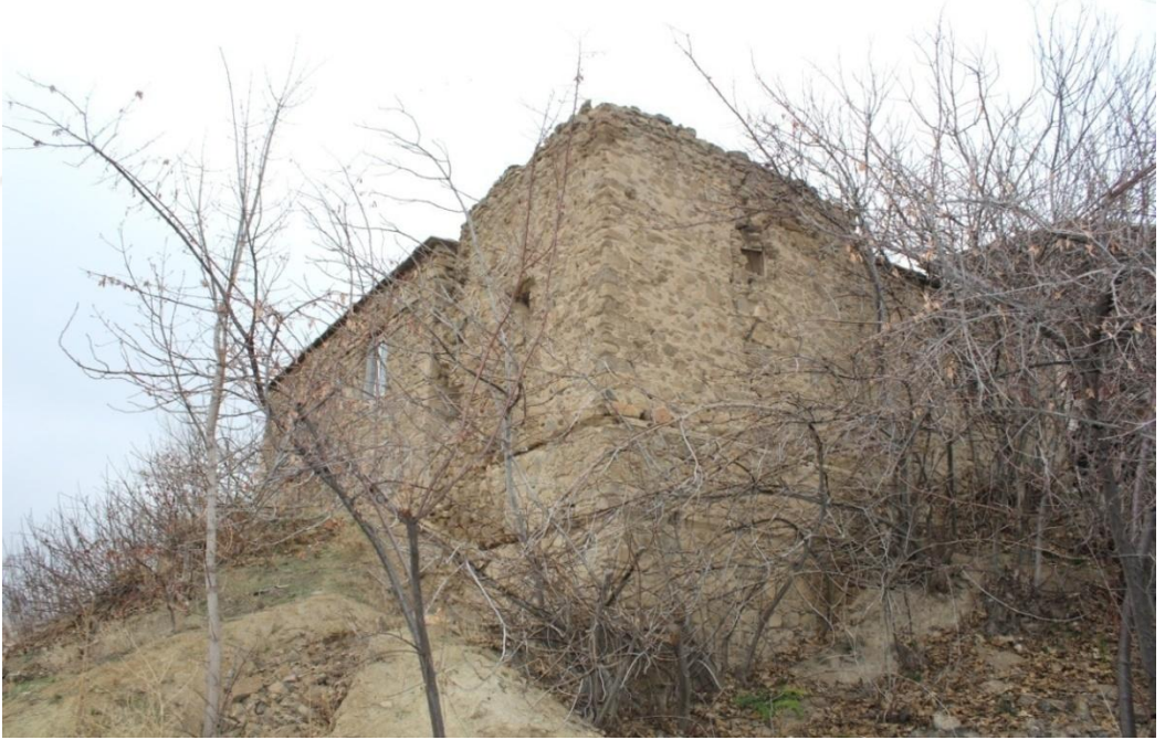
Fotoğraf 177. Elazığ Keban Yusuf Ziya Paşa Konağı Hamamının Güneydoğu Cephesi
