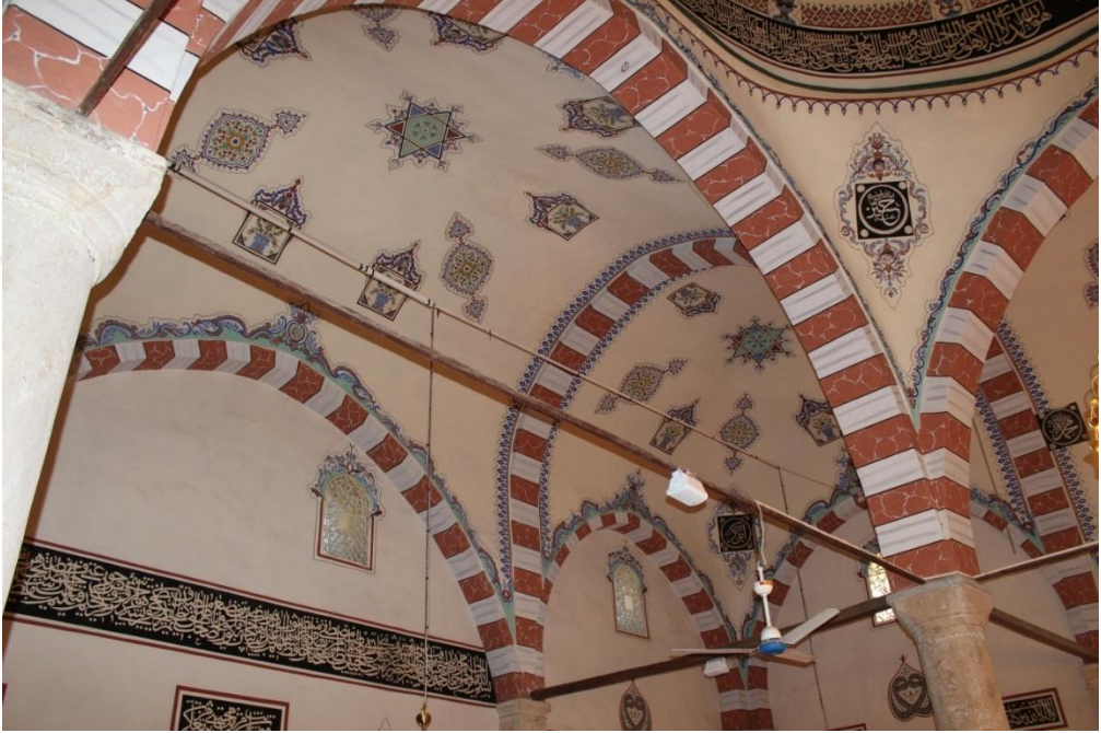
Fotoğraf 84. Keban Yusuf Ziya Paşa Camii Üst Örtü Sistemi
