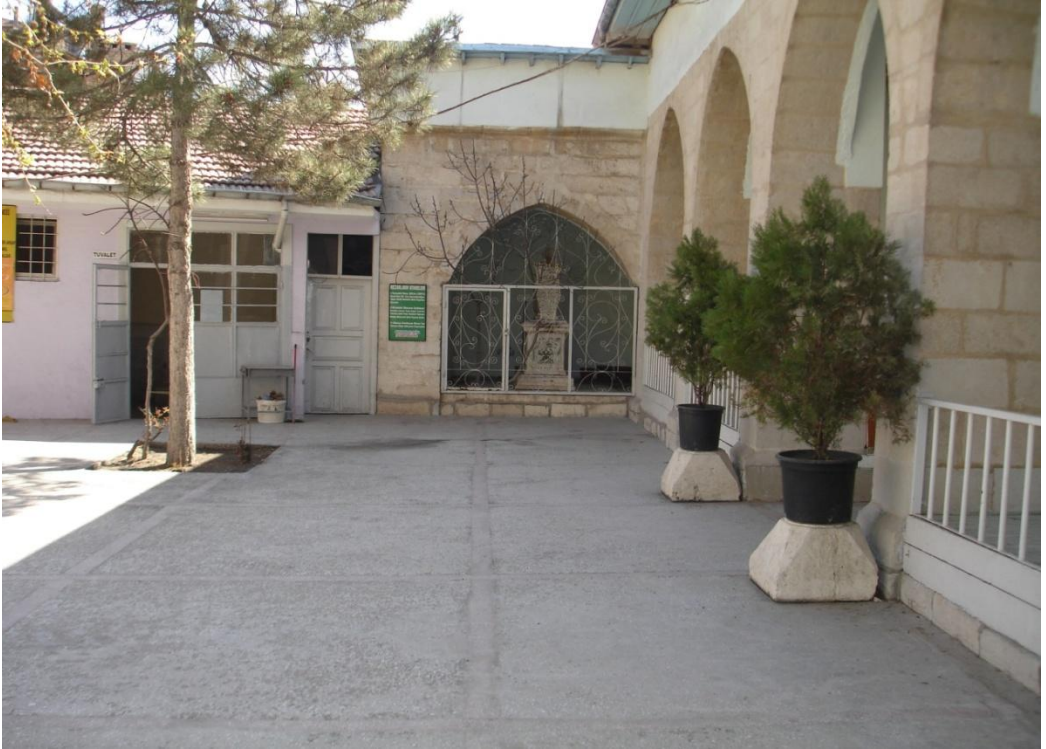
Fotoğraf 30. Malatya Yusuf Ziya Paşa Camii ve Türbesinin Restorasyon Öncesi
