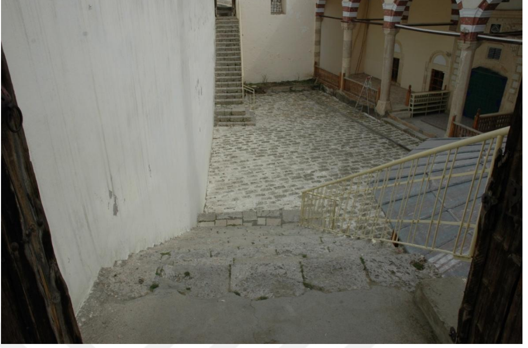
Fotoğraf 47. Keban Yusuf Ziya Paşa Külliyesi Helâların Damından Avluya İnilen Merdivenler
