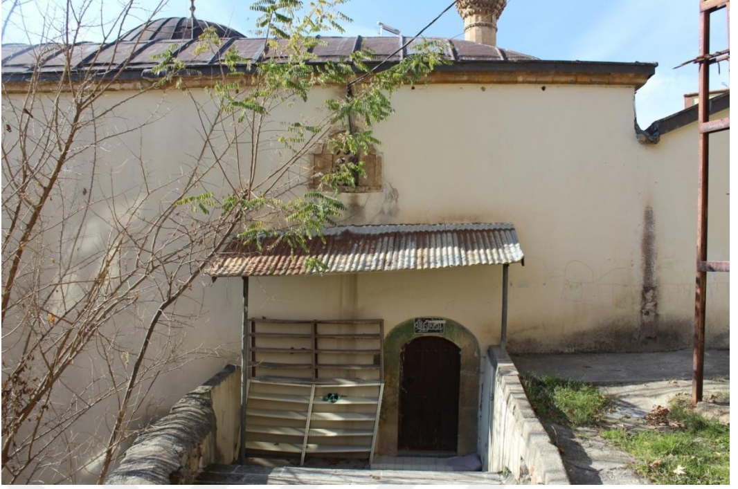
Fotoğraf 57. Keban Yusuf Ziya Paşa Camii Doğu Cephede Hünkâr Mahfiline Giriş Kapısı
