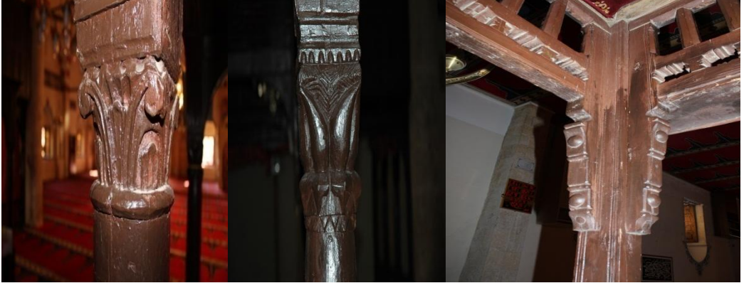
Fotoğraf 101. Keban Yusuf Ziya Paşa Camii Mahfil Taşıyıcı Sistemi
