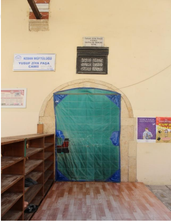
Fotoğraf 74. Keban Yusuf Ziya Paşa Camii Son Cemaat Yerinin Kuzeybatısında Yer Alan Tali Giriş
