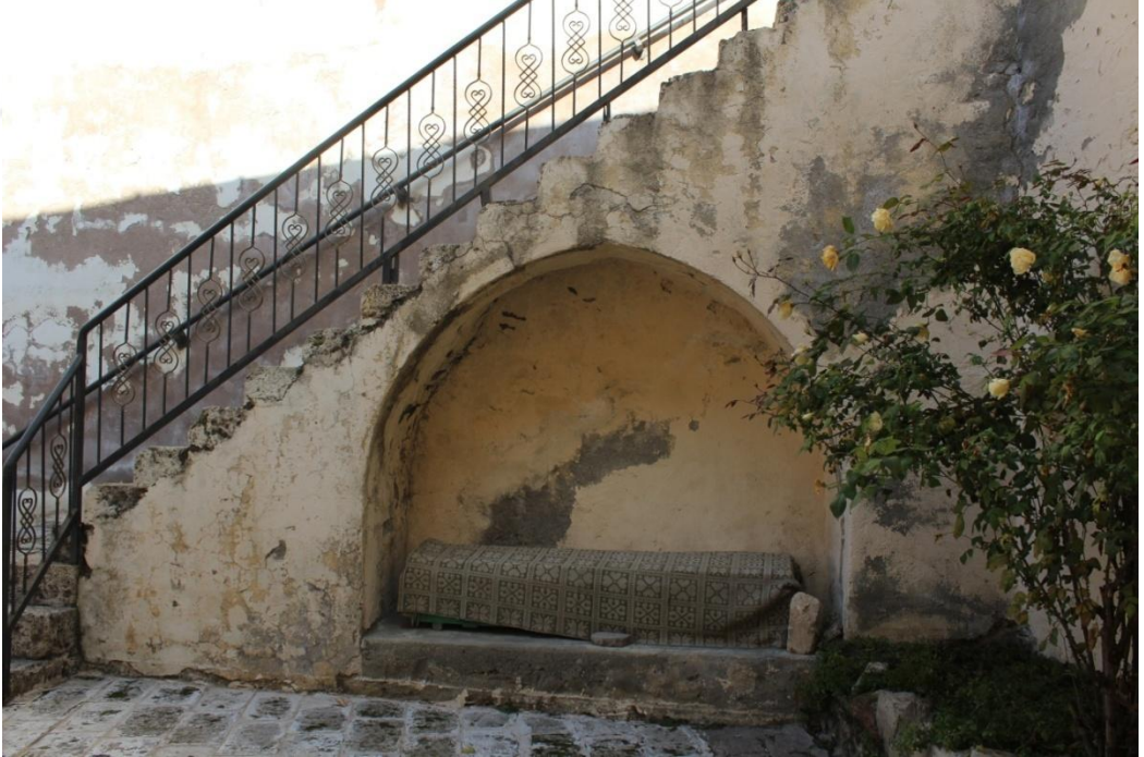
Fotoğraf 48. Keban Yusuf Ziya Paşa Külliyesi Doğu Cephedeki Merdiven Altı
