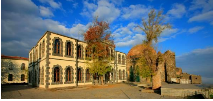
Fotoğraf 224. Yedinci Kolordu Binası Genel Görünüş, 2015
