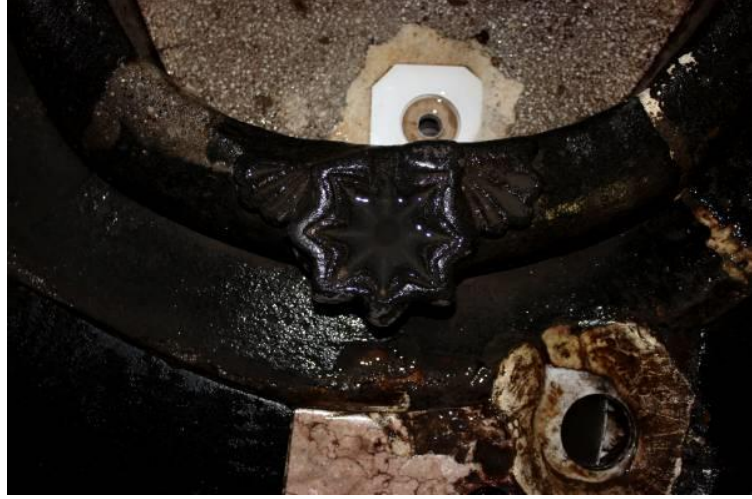
Fotoğraf 209. Hasan Paşa Hanı 2 Nolu Havuz
