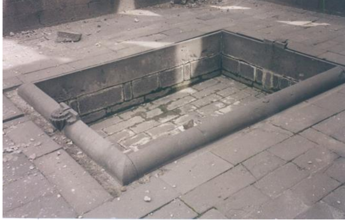
Fotoğraf 61. Cemil Paşa Konağı Selamlık Bölümü 2 Nolu Havuz (Hilmi Okutan'dan, 1999)
