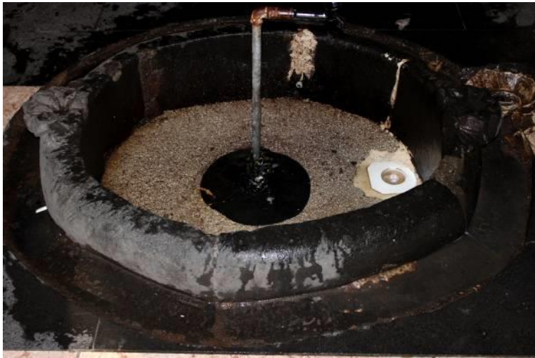
Fotoğraf 208. Hasan Paşa Hanı 2 Nolu Havuz
