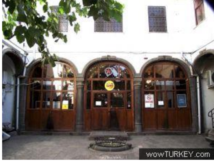
Fotoğraf 221. PTT Binası Genel Görünüş
