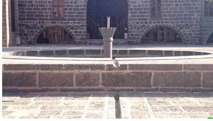
Fotoğraf 58. Cemil Paşa Konağı Haremlik Bölümü
