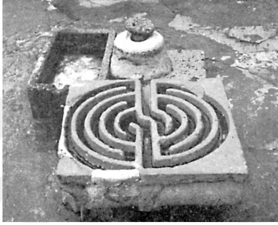
Fotoğraf 232. Diyarbakır Havuzlarında Su Boşaltma Hazneleri
