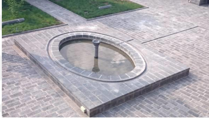
Fotoğraf 56. Cemil Paşa Konağı Haremlik Bölümü
