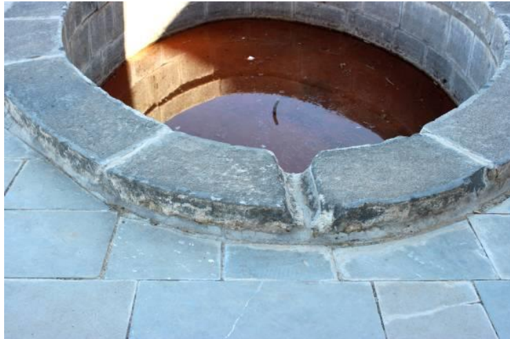
Fotoğraf 226. Yedinci Kolordu Binası Havuzu, 2015
