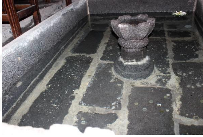
Fotoğraf 170. DİKTUMDER Binası Havuzu Su Fıskiyesi
