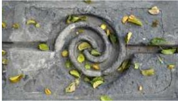
Fotoğraf 233. Kayseri Güpgüpoğlu Konağı Havuz Boşaltma Haznesi
