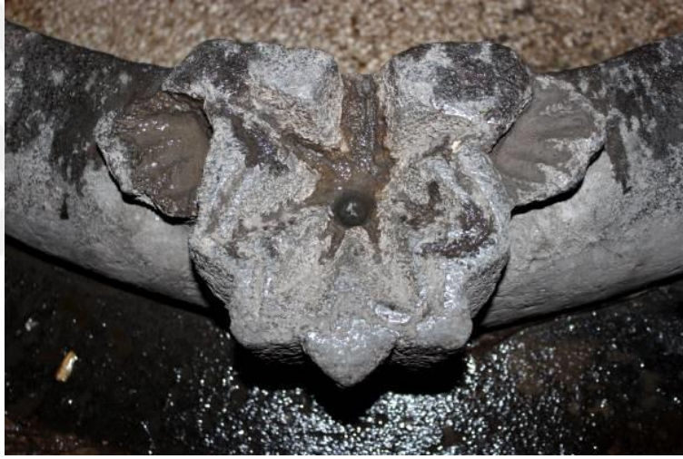
Fotoğraf 210. Hasan Paşa Hanı 2 Nolu Havuz
