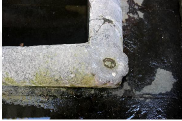
Fotoğraf 136. İskender Paşa Konağı Havuz Güney Köşesinde Yer Alan Su Kadehlerinden Görünüş
