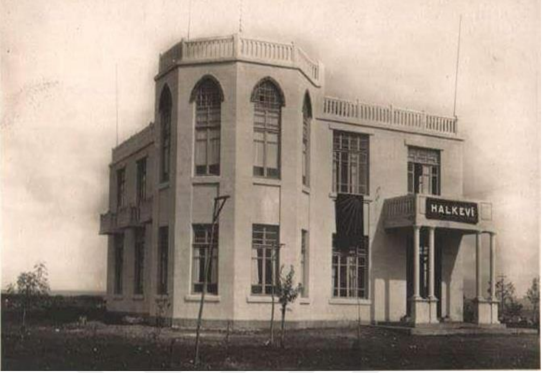
Ek 15. Diyarbakir Halk Evi Binasi
