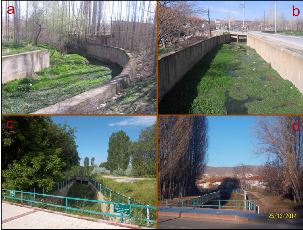
Foto 21. Şalgösteren Deresi üzerinde yapılan taşkın koruma kanalları (a,b), Sellik Deresi üzerinde taşkını önlemek için yapılan kanallar (c,d).
