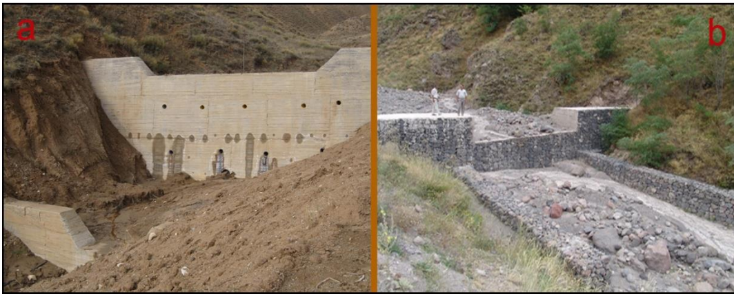
Foto 22. Kılıçözü Çayı yan kolları üzerinde düzenli akışı sağlamak için yapılan ıslah sekileri (a,b).
