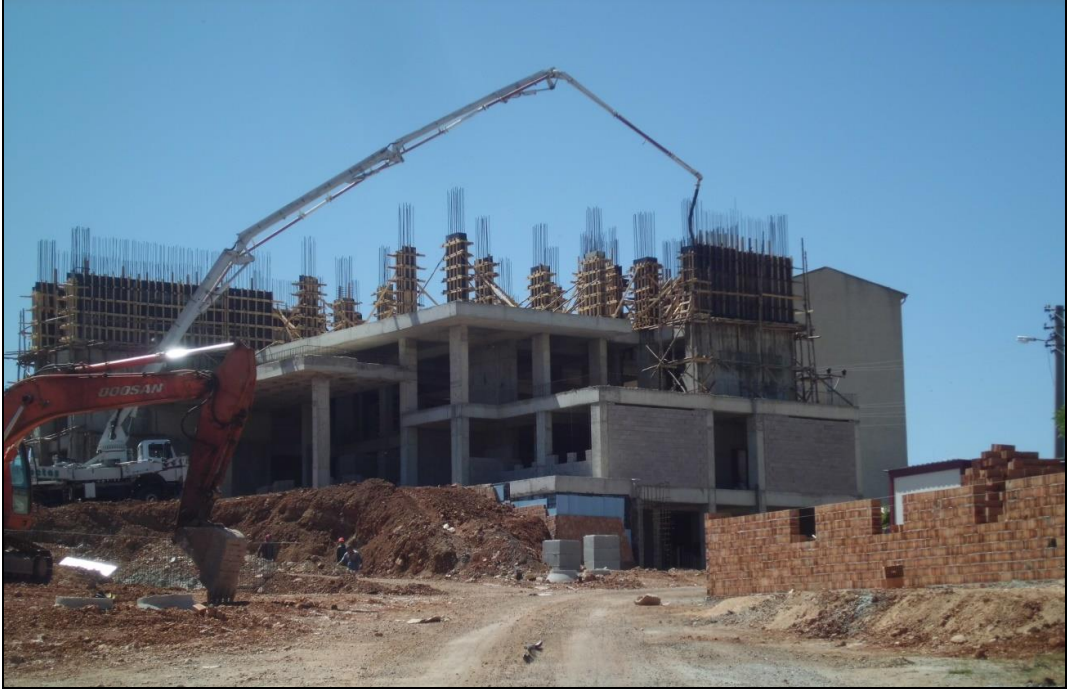
Fotoğraf 22. Doğanşehir Yeni Devlet Hastanesi İnşaatından Bir Görünüm
