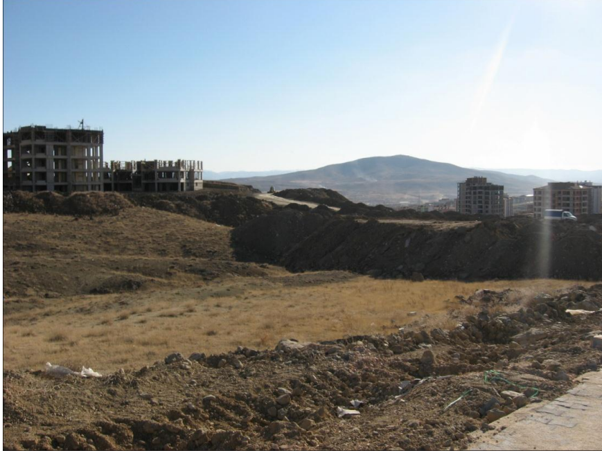
Foto 12. Elazığ Teknokent'in güneyinde vadilerin doldurulması ve çevresindeki yapılaşma
