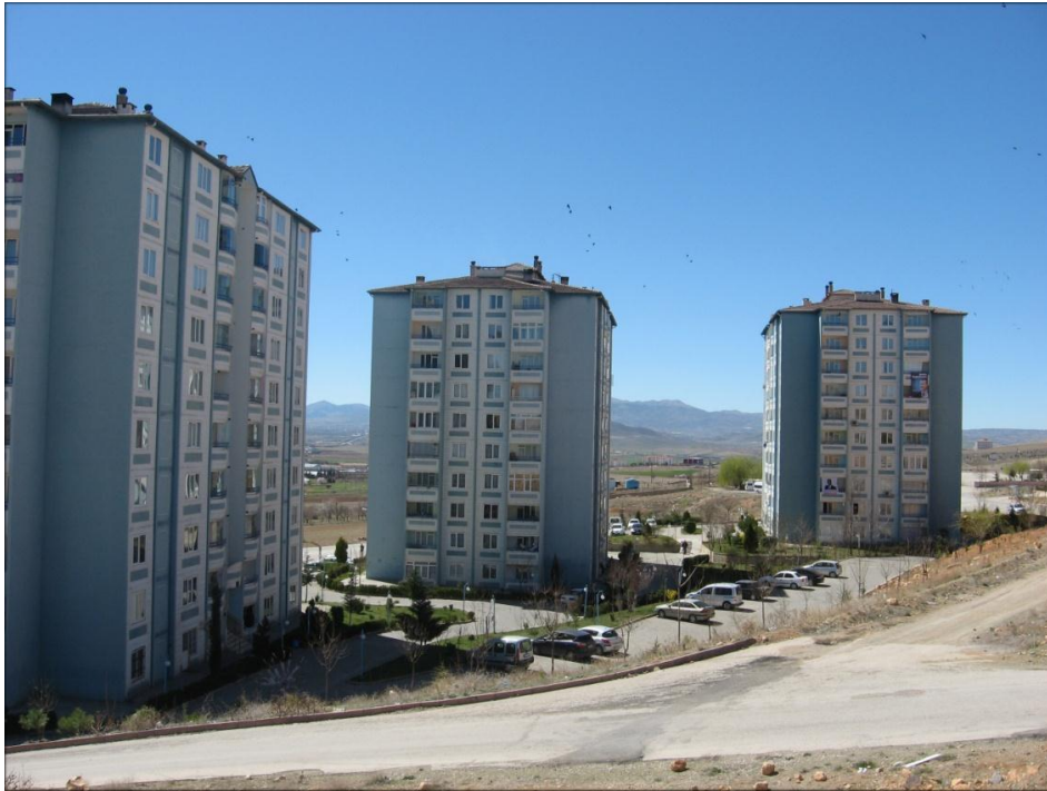
Foto 8. Elazığ Hilalkent mahallesinde oluşan basamaklar
