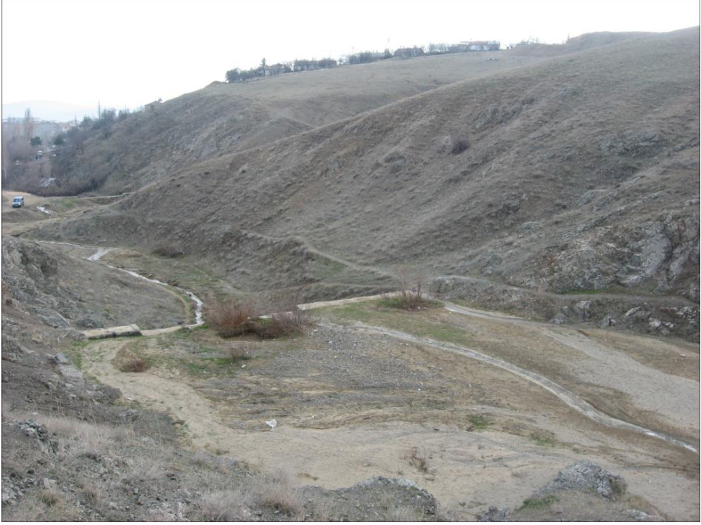
Foto 13. Esentepe mahallesinin batısında vadi içine yapılan bent ve gerisinde meydana gelen siltasyon
