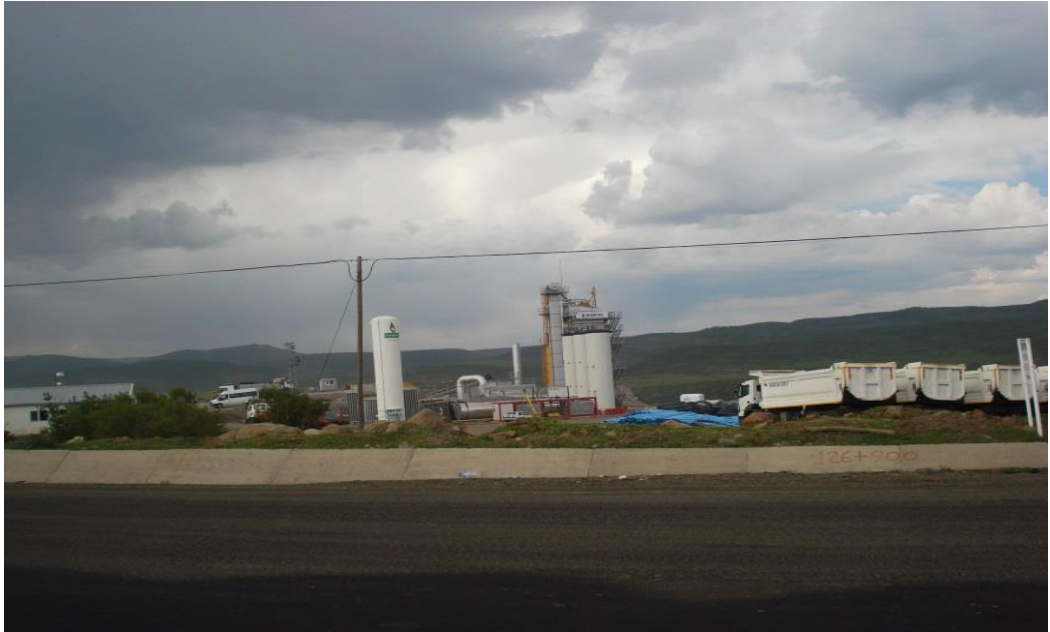
Foto 16. Bingöl Elazığ karayolu üzerinde yer alan asfalt şantiyesi
