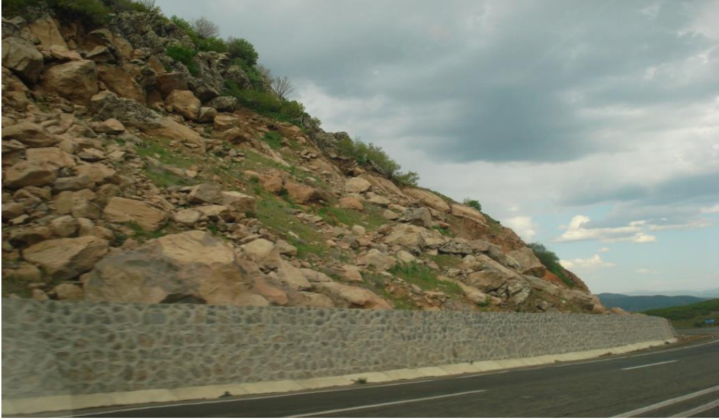
Foto 6. Karayolunda kaya düşmesi engellemek için yapılan istinat duvarı
