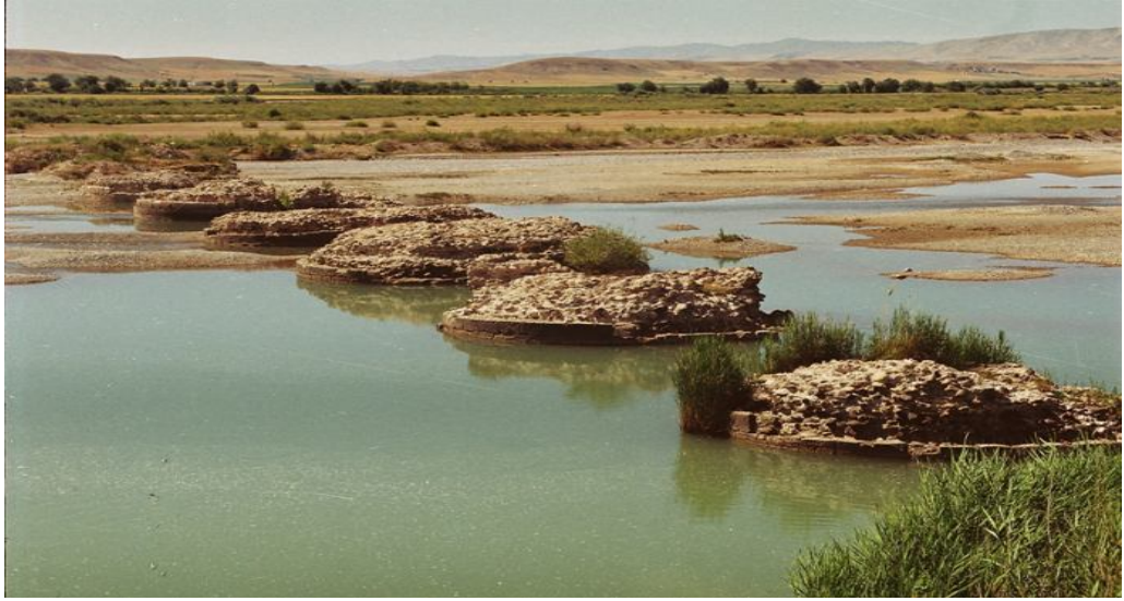
Foto 10: Batman Şehri Yakınlarındaki Pira Perpira Köprüsü Ayaklarından Bir Görünüm
