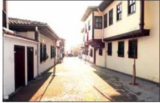
Dutlu Sokak'ın Sokak Sağlıklaştırma Projesi sonrası durumu
