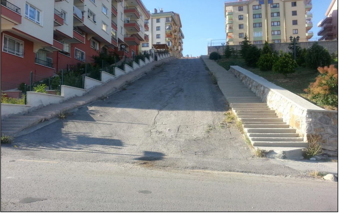
Foto 17: Yahya Mahallesi 1512. Sokaktaki Merdivenli Yol; Topografyanın elverişsiz olduğu yerlerde kara yolunun kenarında çift taraflı merdivenli yaya yolları son dönemlerde Keçiören’de sıkça görülmeye başlanmıştır. Bu merdivenli yol yapımı kısa mesafelerde eğim farkından kaynaklanmaktadır. Fakat konutların topografyanın olumsuz koşullarını gözardı ederek gelişmesi, merdivenli yol yapımına neden olmuştur.
