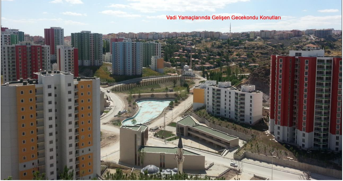
Foto 34: Kuzey Ankara Dönüşüm Alanı; Kentsel dönüşüm ile birçok gecekondu dönüştürülmesine rağmen Hacıkadın dere yatağında bulunan gecekondu planlama kapsamına alınmamıştır. Vadi içinde gelişen gecekondu yerleşmeye uygun olmayan çok eğimli yamaçlarda gelişmiştir.
