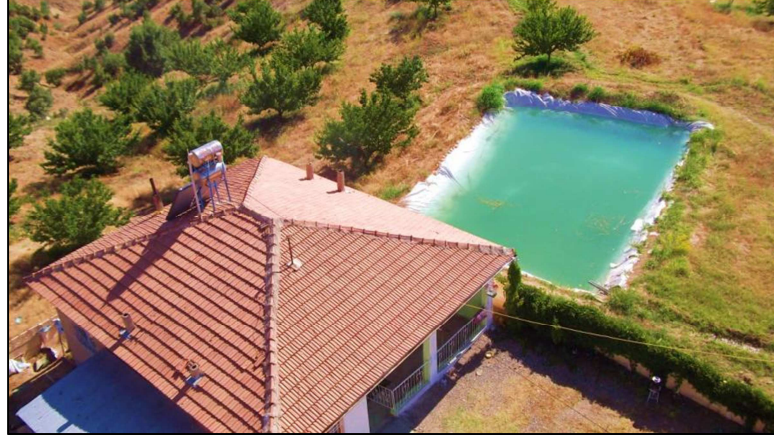
Fotoğraf 9. Kırmızı Çatı ve Kayısı Bahçesi İçin Sulama Havuzu (Topaluşağı köyü). Toprak havuz, toprağın kazılarak içerisine naylon branda serilmesi ile oluşturulmuştur. Bu havuzlar özellikle Topalkem havzasında daha fazla bulunmaktadır.
