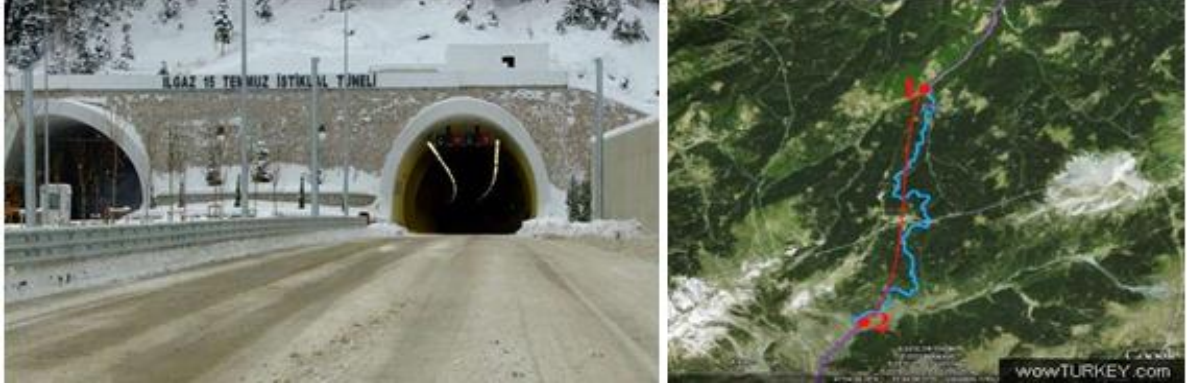
Fotoğraf 31: Ilgaz 15 Temmuz İstiklal Tüneli ve Güzergâhı
