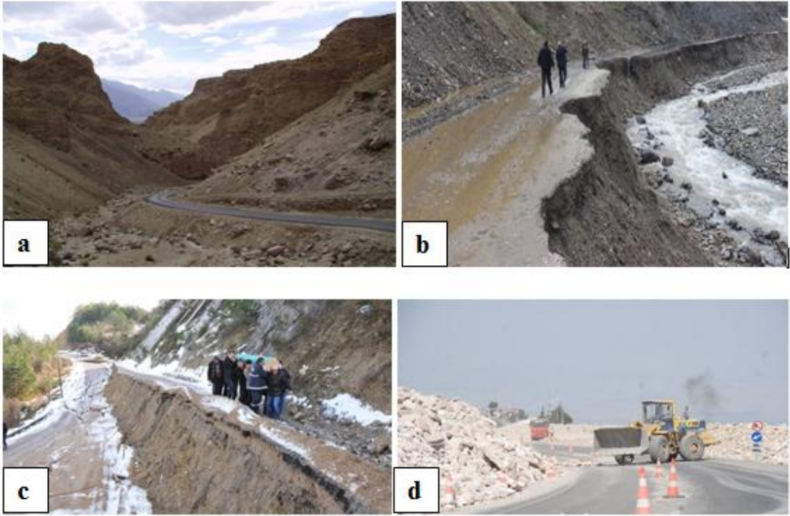
a. Gevşek yapılı litolojiden geçirilen yol güzergahı (kaya düşmeleri sıklıkla yaşanır), b. Heyelan sonucu kayan yol güzergahı (Muş) URL 11, c. Yol güzergahında heyelan (Kastamonu-Sinop Güzergahı) URL 12, d. Belen'de meydana gelen heyelan
