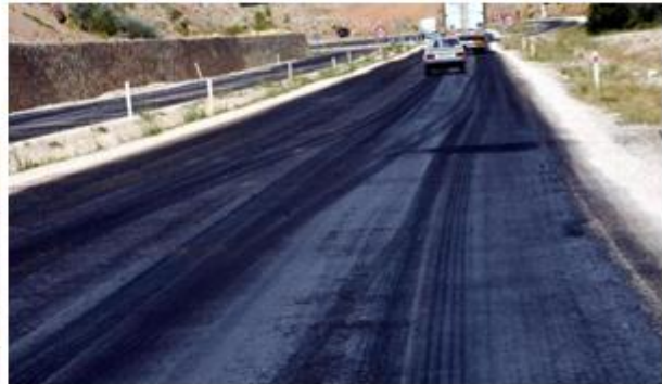
Fotoğraf 19: Sıcaklıkla Eriyen Asfalt
