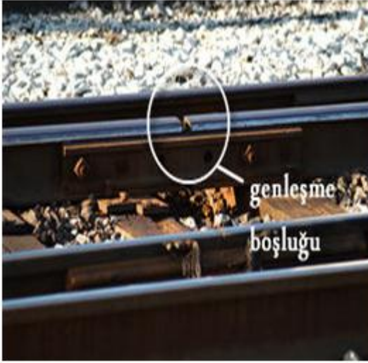
Fotoğraf 20: Raylardaki Genleşme Boşluğu
